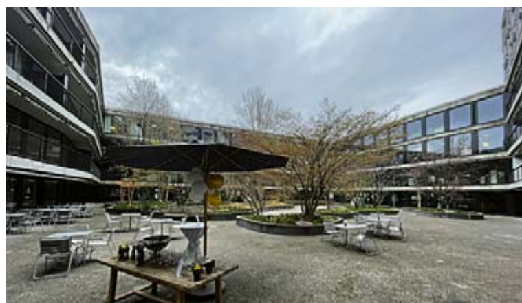
Die Residenz Südpark lädt zum Feierabendbier inmitten im Gundeli in die Grüne Oase über dem Coop-Center.
