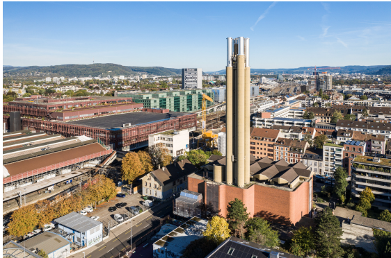
Heizwerk Bahnhof (©Simon Havlik)
