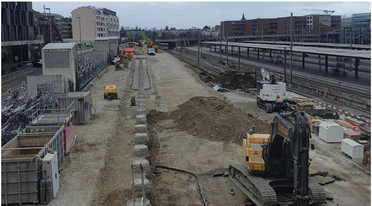
*Das Foto vom 8. März 2023 zeigt die bereits erstellten Bohrpfähle für die Stützmauer. Sie bilden die sogenannte Bohrpfahlwand. Das ganze Erdreich rechts der Bohrpfähle tragen wir in einem späteren Schritt ab. So schaffen wir Platz für das neue Perron und die neuen Gleise.*
