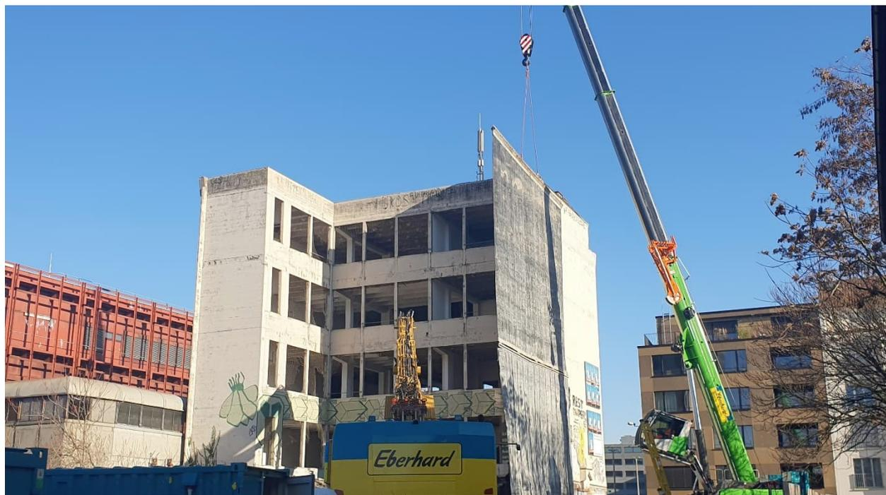
Das Foto vom 14. Februar 2023 zeigt den Abbruch des Gebäudes an der Solothurnerstrasse 4. Unten links im Bild erkennt man den nun gesperrten südlichen Zugang zur Postpasserelle. Der Pneukran rechts stellt mit der Schutzblache sicher, dass bei den Abbrucharbeiten kein Bau-schutt auf die Strasse gerät. Unterdessen ist das Gebäude bis auf den Keller abgebrochen.
